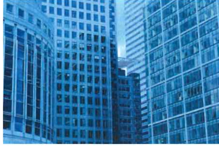
■商業ビル、オフィスの出入口
